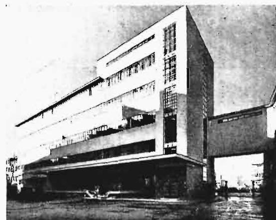
FABRYKA TYTONIU W LINZ. ARCH. P. BEHRENS i A. POPP.
