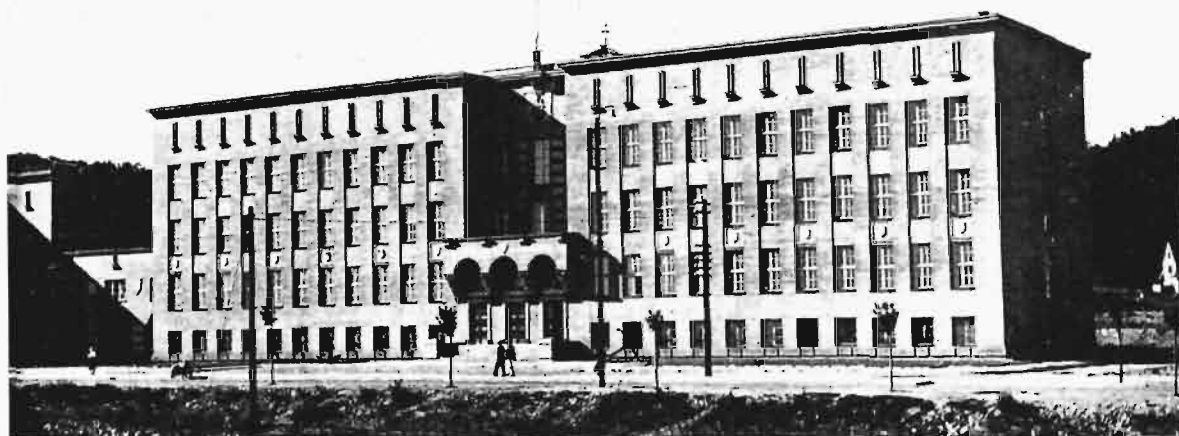
BUDYNEK SZKOŁY MORSKIEJ. Usytuowany przy arterii tranzytowej zdaleka od morza.
