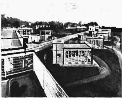
Szkoła na świeżym powietrzu w Suresnes p. Paryżem — Arch. E. Beaudouin i H. Lods. „L'Architecte” 3.1935.
