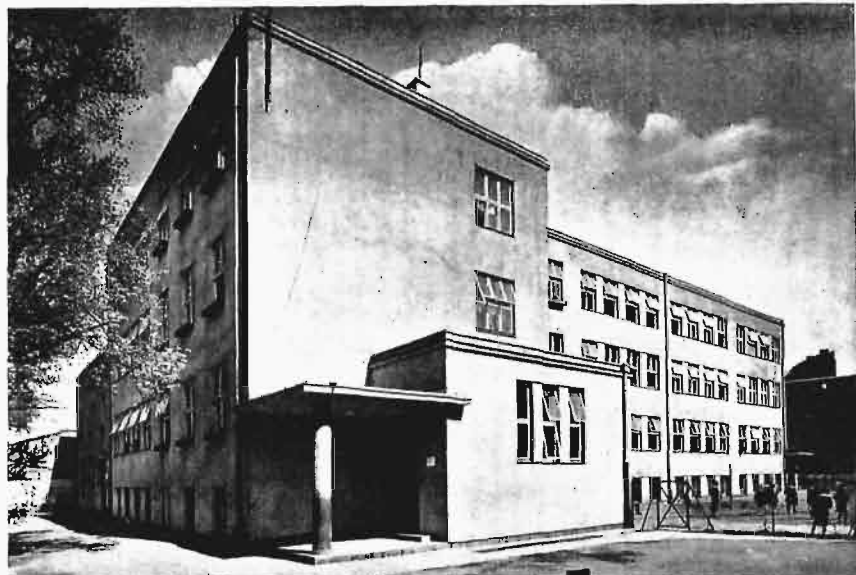
Widok wejścia od strony ogrodu Krasieńskich.
