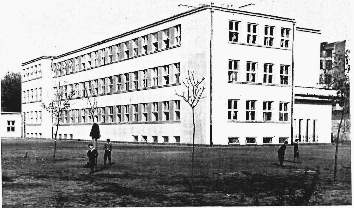
ARCH. JERZY PRZYMANOWSKI. Budynek 3-ch szkół powszechnych przy ul. Spokojnej (Powązki).
