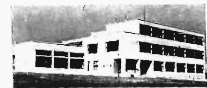
Szkola powszechna w Brünn. — Arch. Kyselka. „Der Baumeister“ 12. 1930.
