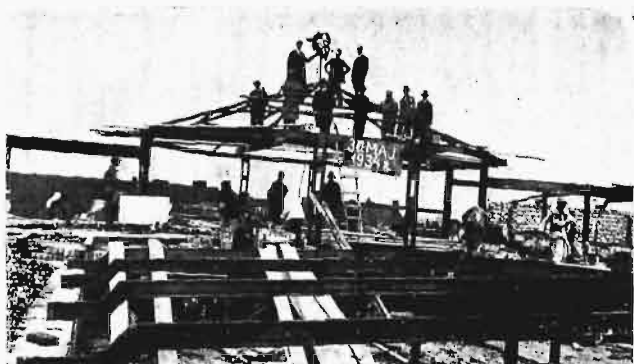
Konstrukcja dachu nad skrzydłami i świetlni nad klatką schodową.
