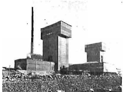
Kopalnia węgla w Faulquemont—Arch. J. Madelaine. „L'Architecture d'A.” 11. 1935.
