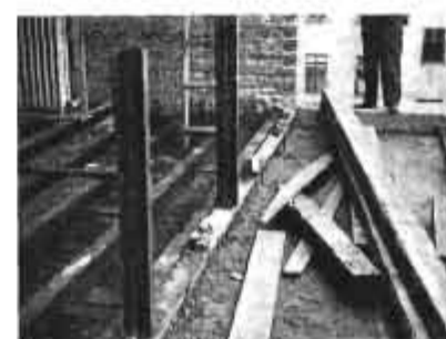
Zdjęcia w czasie budowy.
