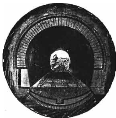
W Londynie przy placu Piccadilly Circus, największa z istniejących kolej podziemna zo- stała uszczelniona HYDROFUGE CASTOREM.
