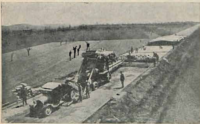
Ryc. 12. Droga samochodowa Bergamo—Brescia. Budowa nawierzchni.
