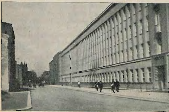
Gmach Śląskiego Zakładu Naukowego w Katowicach.
