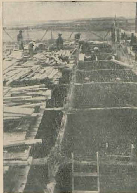
Rys. 5. Komory silosów w budowie.
