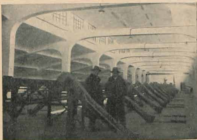
Rys. 6. Dach nad komorami.
