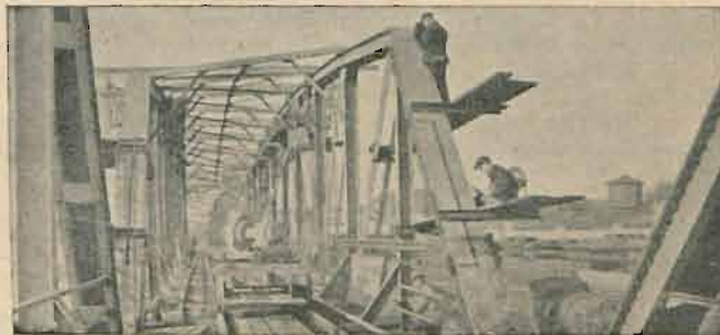
Fig. 1. Wzmocnienie mostu stalowego kolejowego.
