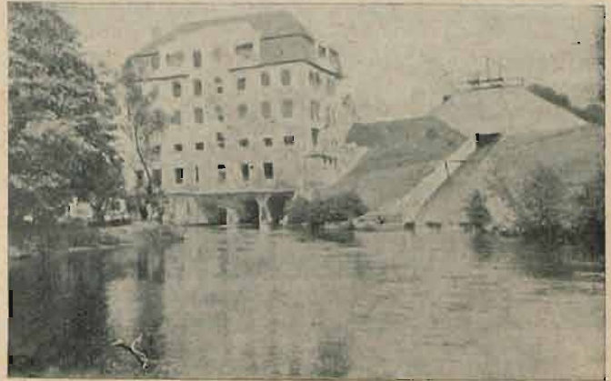
Ryc. 18. Gródek. Zakład turbinowy i przepust dla traw.
