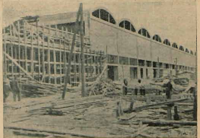
Ryc. 21. Gdynia. Budowa dworca morskiego.
