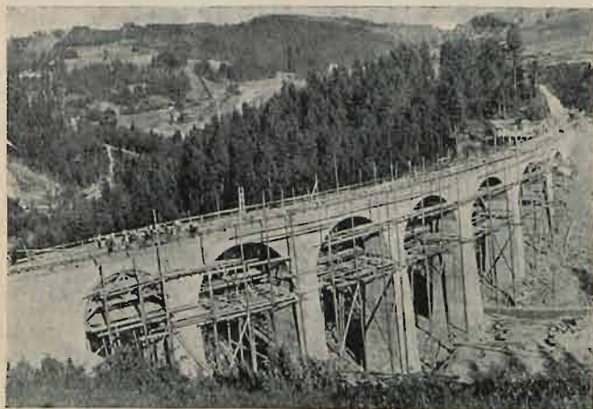
Ryc. 4. Budowa kolei Wisła-Głębce. Wiadukt w dolinie Łabajowej.
