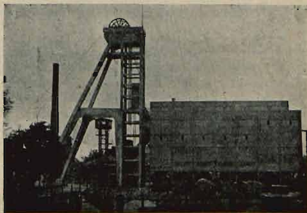
Ryc. 5. Królewska-Huta. Wieża wyciągowa żelbetowa kopalni prez. Mościckiego.
