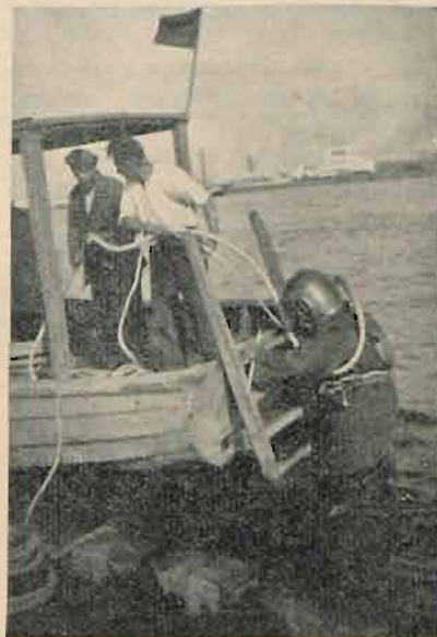
Ryc. 12. Nurek Urzędu opuszcza się na dno celem sprawdzenia szczelności palisady.
