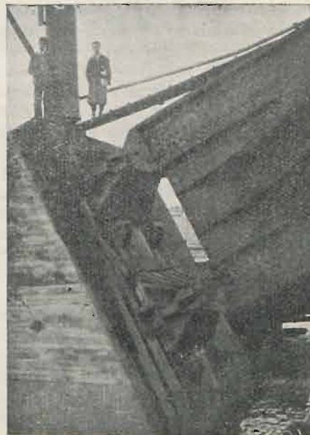
Ryc. 5. Västerbron. Łożysko i przyczółek większego łuku.
