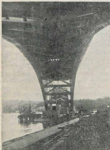
Ryc. 4. Västerbron. Widok s.podu Konstrukcji.
