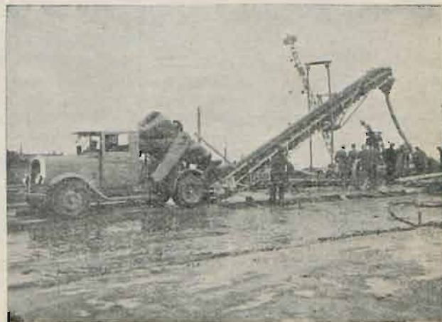
Ryc. 6. Västerbron. Betonowanie pomostu.
