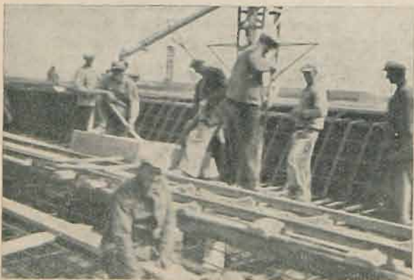
Ryc. 6. Betonowanie kesonu.
