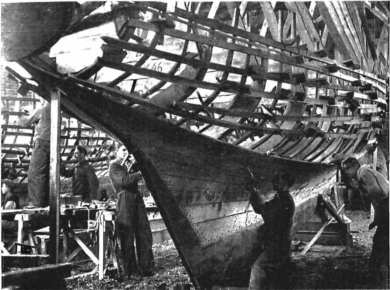
Stocznia Jachtowa w Gdyni. -- Kładzenie poszycia.
