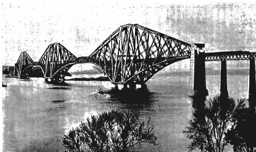
Widok ogólny mostu kolejowego na rzece Forth w Szkocji
