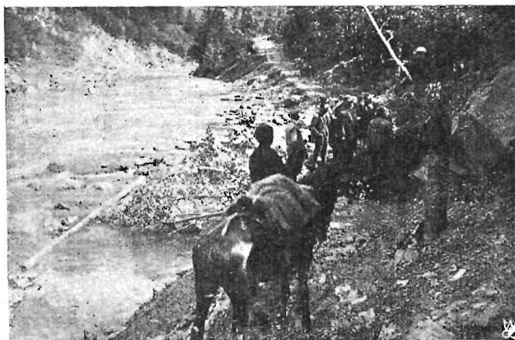
Osunięcie się zbocza na drogę nad Czeremoszem między Jawornikiem a Zelenem.
