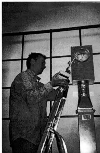
Rysunek 9.26. Widok autotransformatora sterującego wydatkiem wentylatora.
