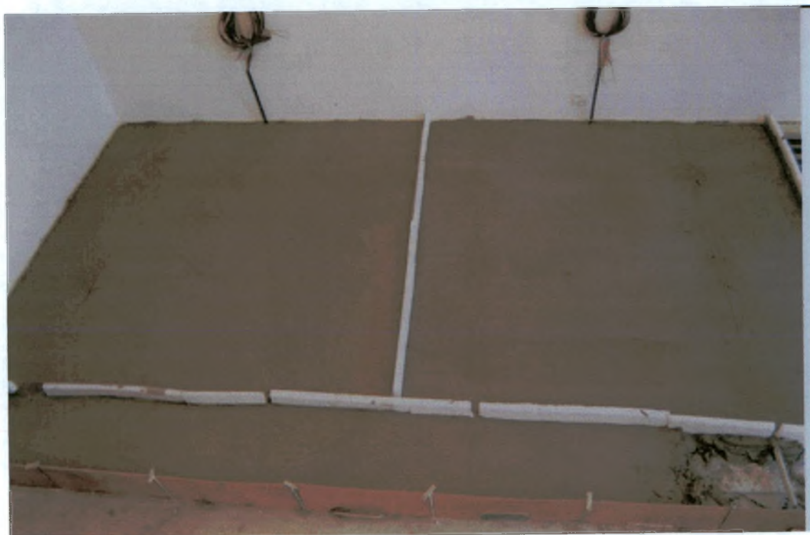
Rys. 7.7. Wężownice o rozstawie rur B = 15 cm i B = 20 cm po wylaniu warstwy jastrychu, bez warstwy wykończeniowej. Zdjęcie wykonane podczas budowy stanowiska.
