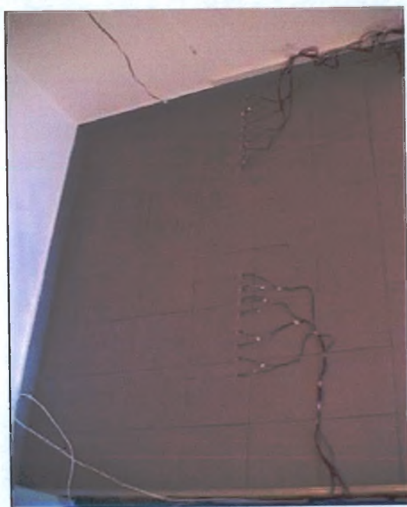
Rys. 7.8. Wężownica o rozstawie rur B = 15 cm po ułożeniu warstwy wykończeniowej. Zdjęcie wykonane po zakończeniu budowy stanowiska.
