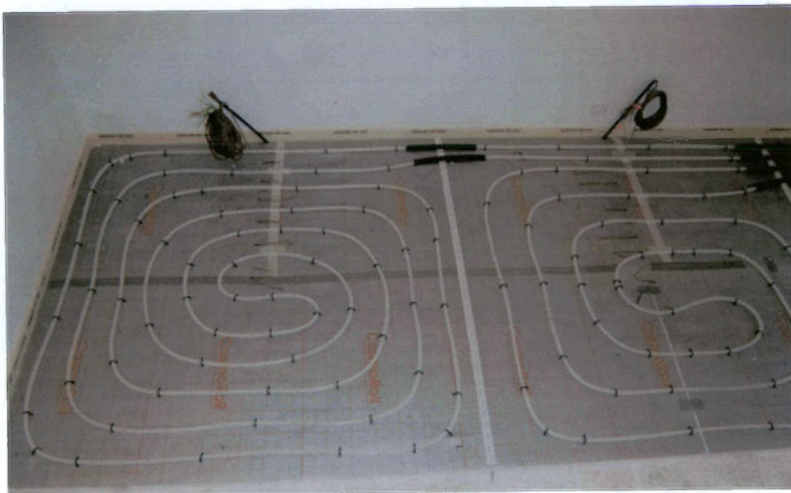
Rys. 7.1. Grzejnik podłogowy o rozstawie rur B = 15 \text{ cm} i B = 20 \text{ cm} . Zdjęcie wykonane podczas budowy stanowiska.
