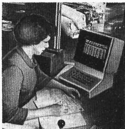
Rys. 5-5. Teledator ekranowy zastosowany do ewidencji i dyspozycji sprzedaży części zamiennych do samochodów
