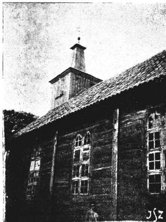
Wiz : 43. Kościół drewniany w Jastarni koło Heli. Okno czysto polskie podwójnie dwudzielne w kierunku poziomym, zaś poczwórnie dwudzielne w kierunku pionowym. Pola pojedyncze wedle „Kątomira”.
