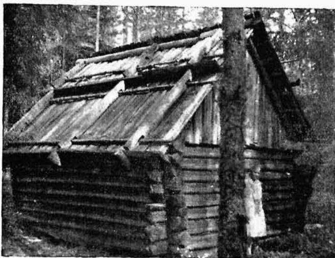
Abb. 38. Satteldach mit Legsschindeldeckung. Kreis Talsi.
