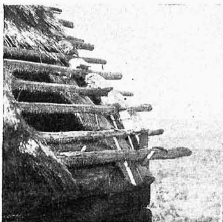
Abb. 40. Giebel in Blockbau mit eingespannten Dachlatten, Kreis Valmiera.
