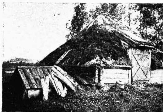
Abb. 35. Zeltdach auf niedrigen Blockwänden, Kreis Liepaja.
