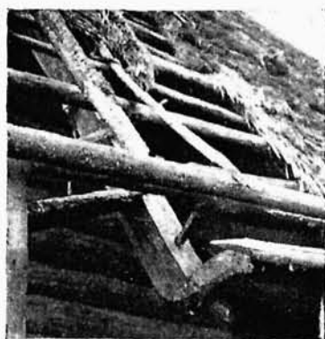
Abb. 42. Sparren mit Wurzelhaken. Kreis Cesis.
