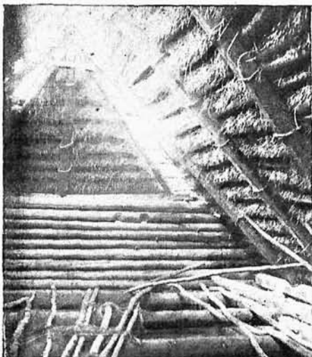
Abb. 32. Freitragendes Sparrendach mit Ankerbalken. Kreis Bauska.
