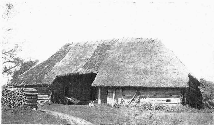
Abb. 46. Strohdach mit Dachreitern. Kreis Cesis.
