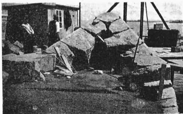
Ryc. 11. Murowanie filara.
