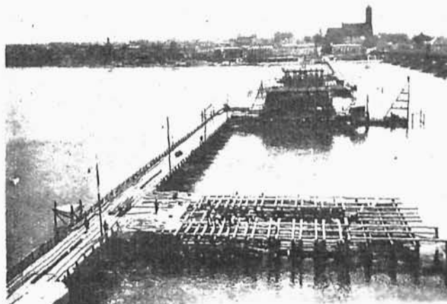
Ryc. 8. Mostki pomocnicze, pomosty i rusztowania kesonów.
