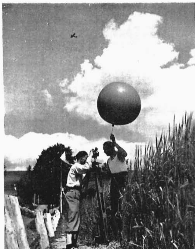
Pomiary aerologiczne dla ustalenia prądów wznoszących przy pomocy baloników i samolotu motorowego
