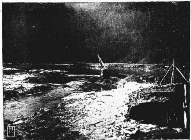
Ryc. 5. Przekopywanie górnej grobli dla przełożenia rzeki
