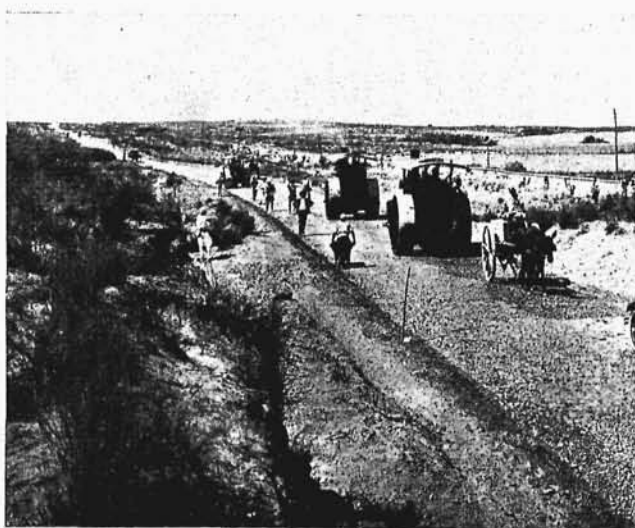
Budowa dróg w Libii odbywa się w trudnych warunkach pustynnych. Widoczna na zdjęciu trawa „sparto” chroni drogę przed działaniem piasku niesionego wiatrem
