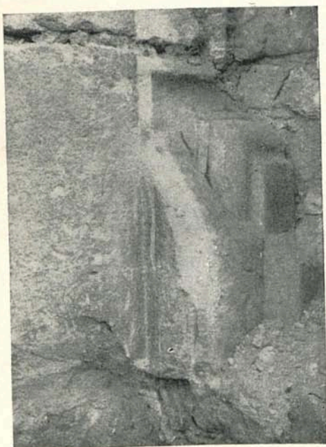
Ryc. 13. Cokolik profilowany na dolnym ciosie zachowanego fragmentu portalu zachodniego.
