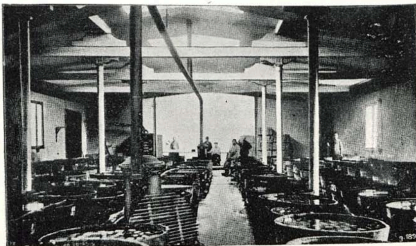
Ryc. 1. Jedna z sal Berlińskiego Laboratorium Chemicznego. Kadzie do konserwacji płyt kamiennych.
