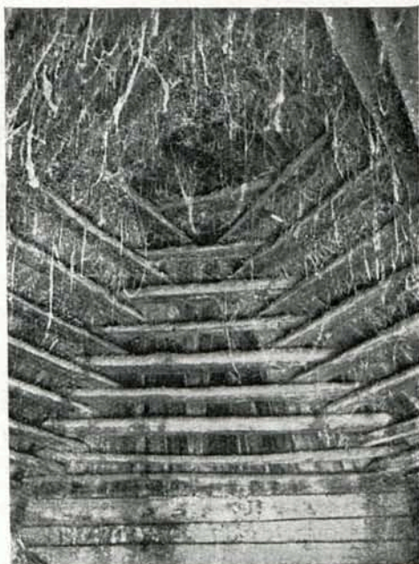
Ryc. 16. Konstrukcja dachu — pułap sto- doły A. Pyszniaka w Starem Siole.
