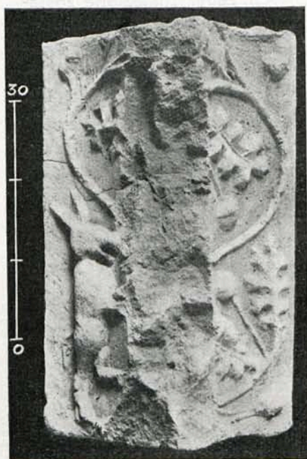
Ryc. 14. Gniezno, Katedra. Element żebra międzyprzęstłowego. Widok od spodu.
