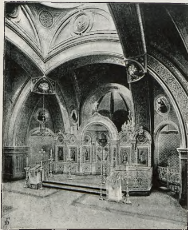
А. О. Вернардацци.—Внутр. видъ Греческ. церкви въ г. Кишиневѣ.
