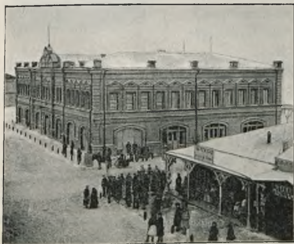
Е. К. Торлинь.—Зданіе для городскихъ учреждений въ г. Гомелѣ.
