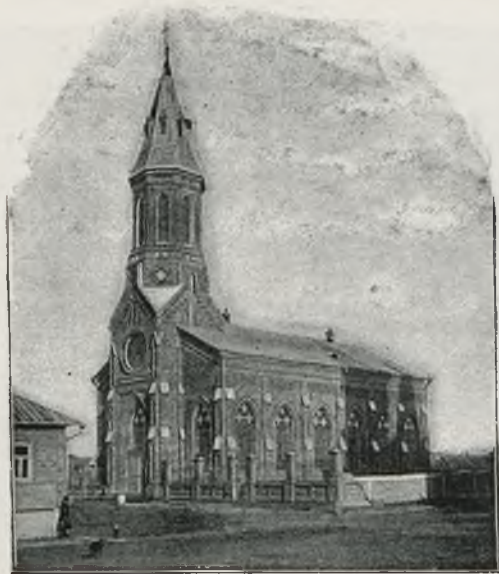
К. К. Домонтовичъ.—Лютеранская церковь въ г. Астрахани.
