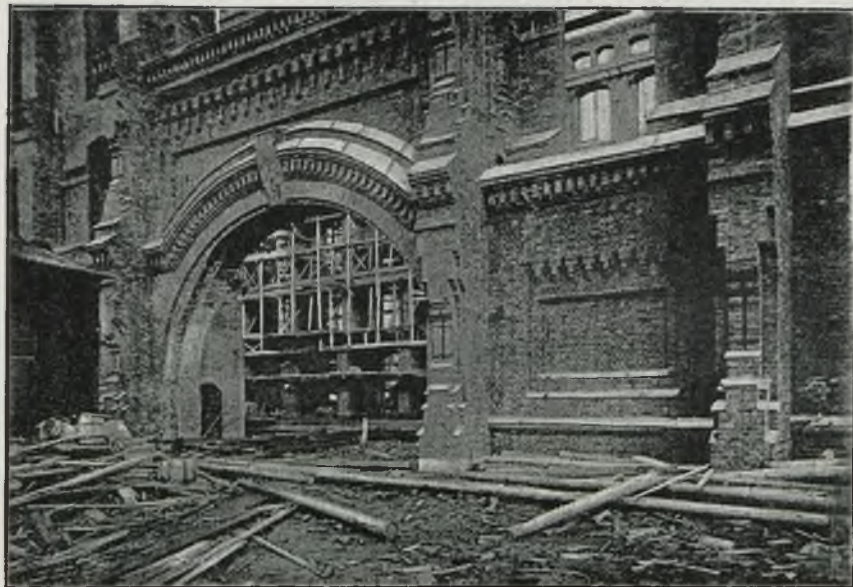
А. Ю. Новицкій.—Новый кам. эллипсъ на балт. судостроит. зав. въ СПб. Фасадъ продольной стѣны (въ постройкѣ).
