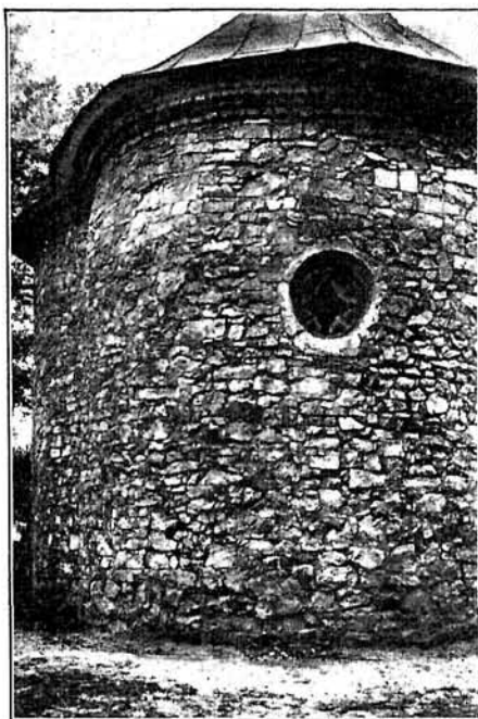
Ryc. 231. Absyda po odbiciu tynków.
