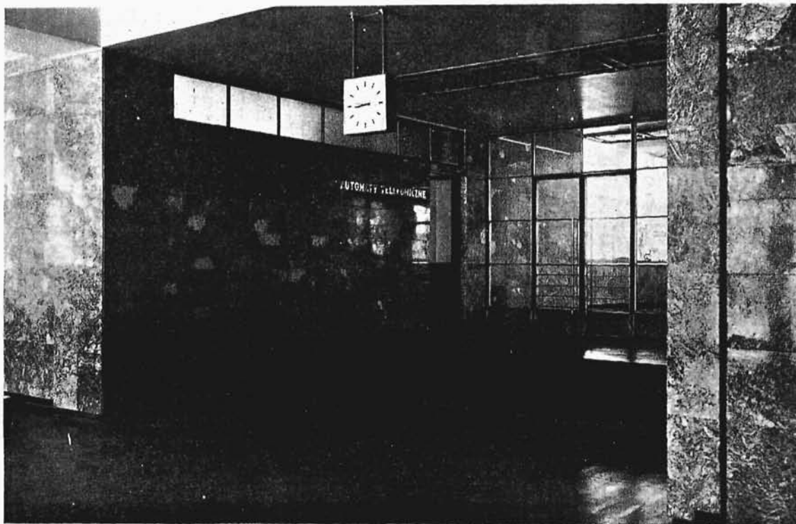
Hall i wejście do sali telefonów międzymiastowych. Arch. Julian Puterman (Warszawa). Gmach Urzędu Telekomunikacyjnego w Warszawie.
