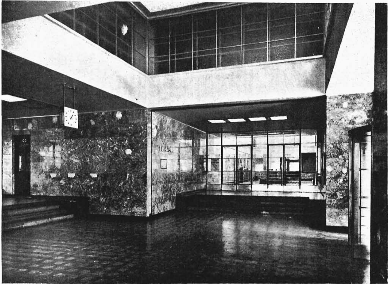
Hall i wejście do sali telegrafu.
