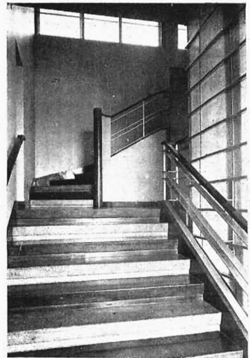
Wyjście na taras wieżowy.
