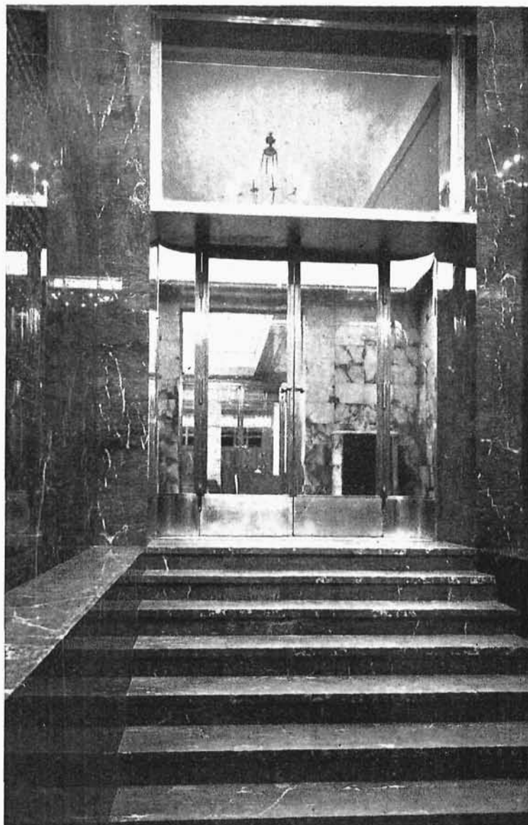
Fot. Cz. Olszewski. Drzwi alpakowe wyk. f. „H. Zieleziński, wł. Kornel Kubacki inż.”, Warszawa. Arch.: Marcin Weinfeld (Warszawa). Gmach „Prudential House” w Warszawie.
