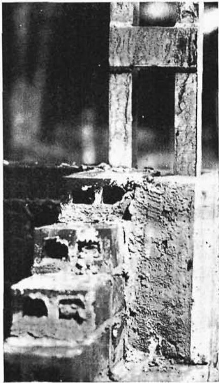
Konstrukcja ścian wypełniających w szkieletach stalowych.
