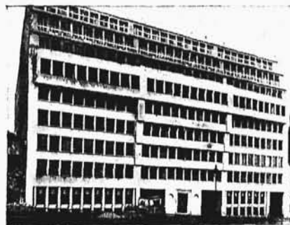
Dom z pracowniami rzemieślniczymi w Paryżu. Arch. F. Saulnier i R. Bonhier.
