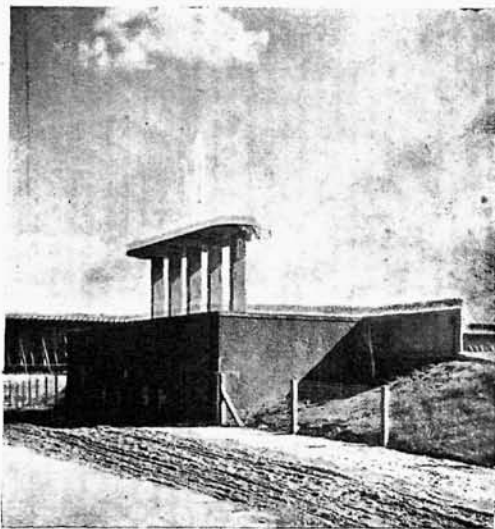
Budynek filtrów od strony wejścia.
