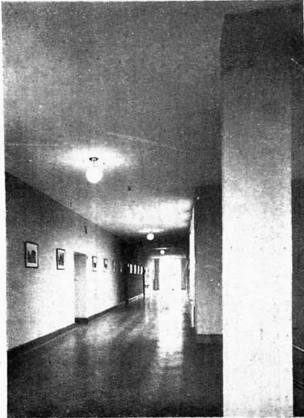
Korytarz II piętra.
