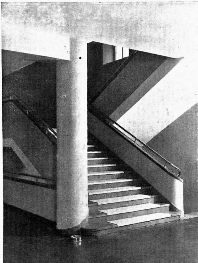
Fragment klatki schodowej.
