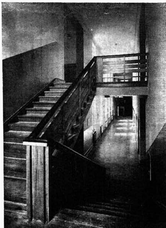
Fragment klatki schodowej.
