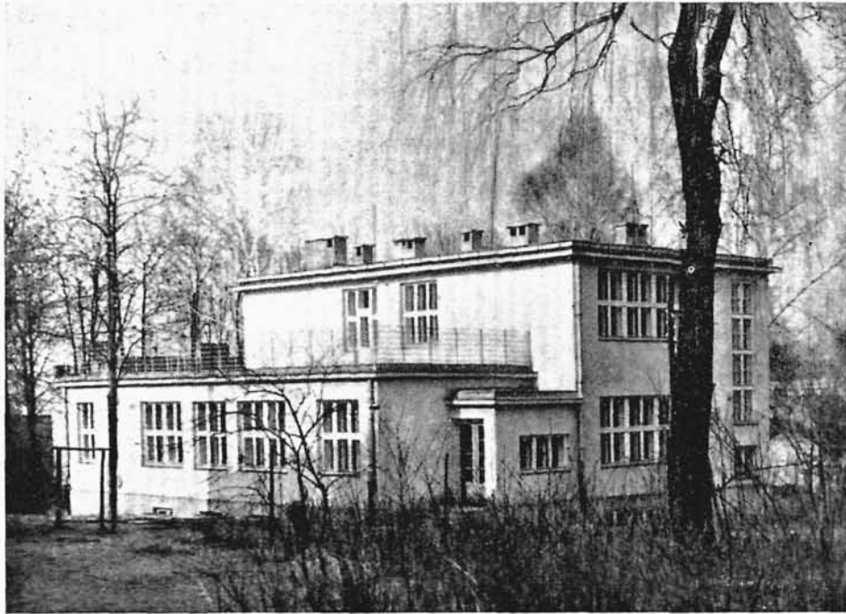
Urządzenie centralnego ogrzewania oraz instalację sanitarną wyk. f. „Termo“ Sp. z o. o. (Katowice).
