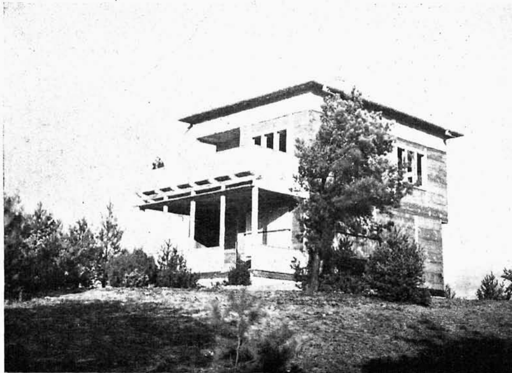
1—3. Arch. Mieczysław Łokcikowski (Warszawa). Dom drewniany nad Wisłą.
