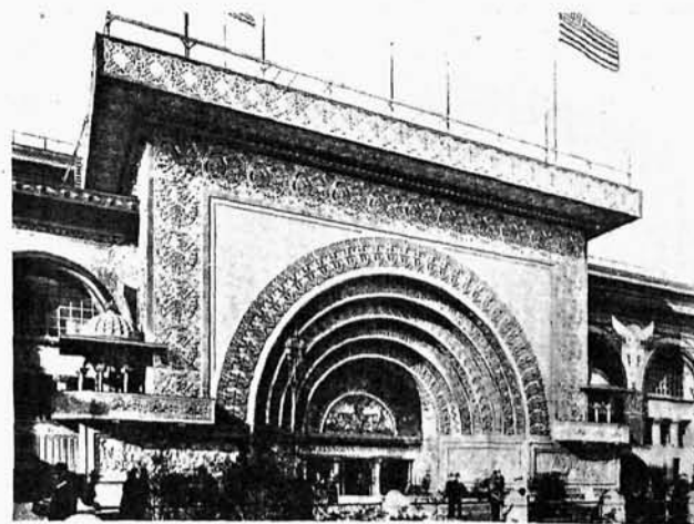
6. Arch.: Adler & Sullivan. Budynek na Wystawie Światowej w Chicago w r. 1893.
