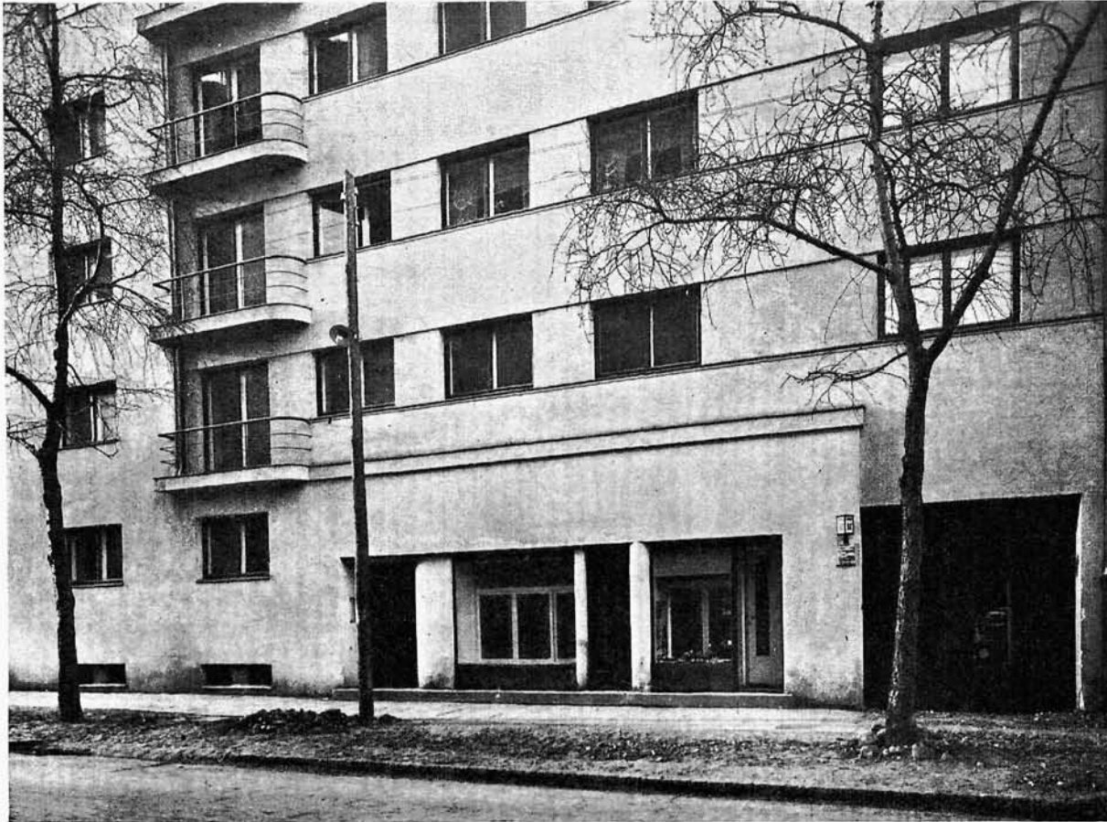
2-3. Arch.: Zygmunt Plater-Zyberk i Juljusz Żórawski (Warszawa). Dom dochodowy przy ul. Chocimskiej w Warszawie.
