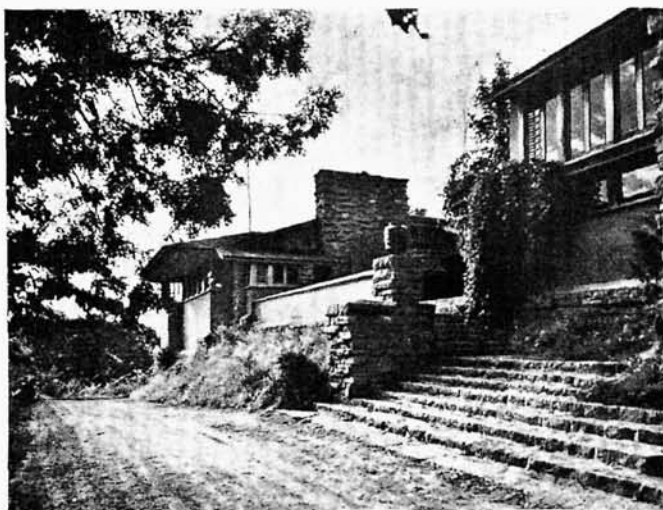
22. Arch. Frank Lloyd Wright. „Taliesin“, dom własny w Spring-Green w St. Wisconsin. Na prawo pracownia, na lewo w głębi dom mieszkalny. R. 1911-26.
