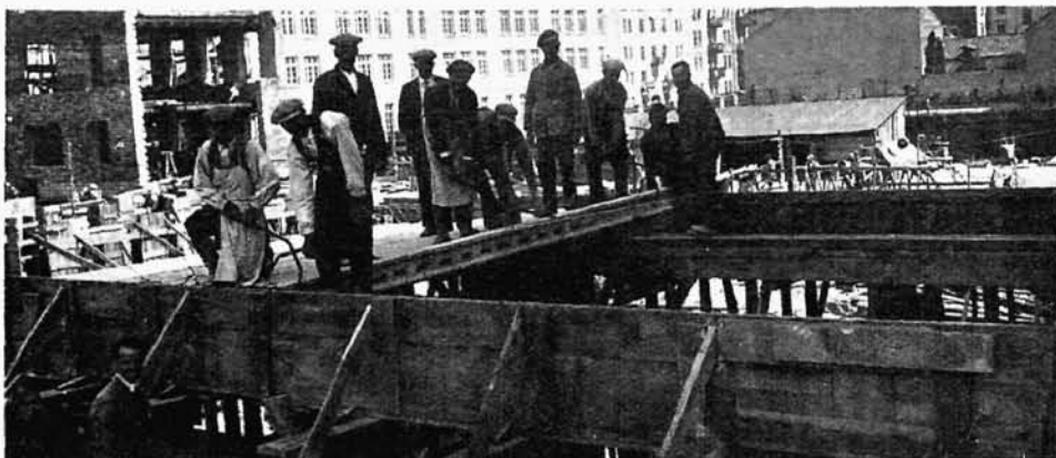
6. Ułożenie stropów składanych typu „Rapid” na budowie gmachu M. R. Publ. w Warszawie.
