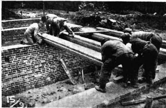
9. Układanie belek stropu składanego.
