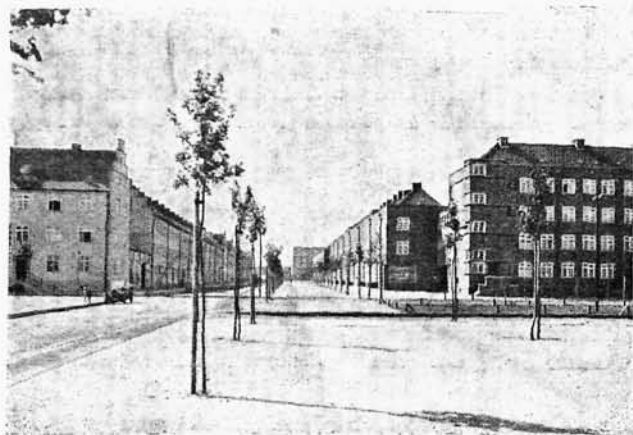
4. Wrzeszcz. Domy czynszowe przy Ringstrasse. Stronę prawą budowali arch.: Kiessling i Krüger.
