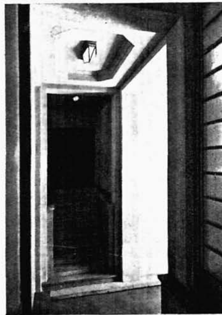
Wejście do mieszkań z bocznej bramy.
