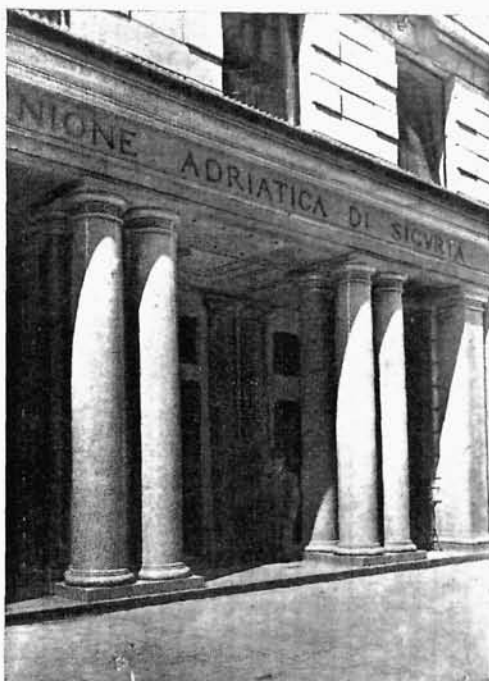
5—6. Arch. Edward Eber (Warszawa). Gmach T-wa Riunione Adriatica di Sicurtà w Warszawie.
