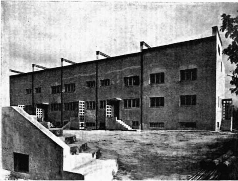
5-7. Arch. Bohdan Pniewski (Warszawa). Spółdzielnia mieszkaniowa „Słońce” w War- szawie.
