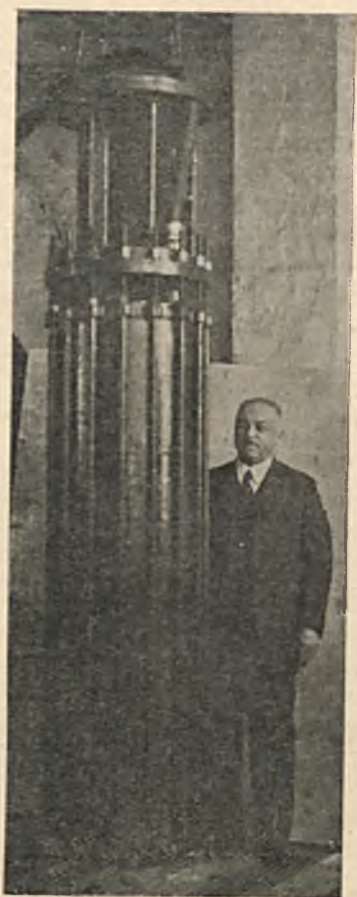
Silnik do Największej na Świecie Pompy Podwodnej „Sirius-SUW” z silnikiem elektrycznym w wodzie — pracującej od 1936 r. w Wodociągach m. Łodzi w studni o głębokości 800 mtr. Moc silnika 250 KM. przy 500 V. i 1470 obr./m. Wydajność pompy 10.000 m 3 /dobę. Konstrukcja i wykonanie Fabryki Maszyn „SIRIUS” Warszawa, Zamojskiego 51.
