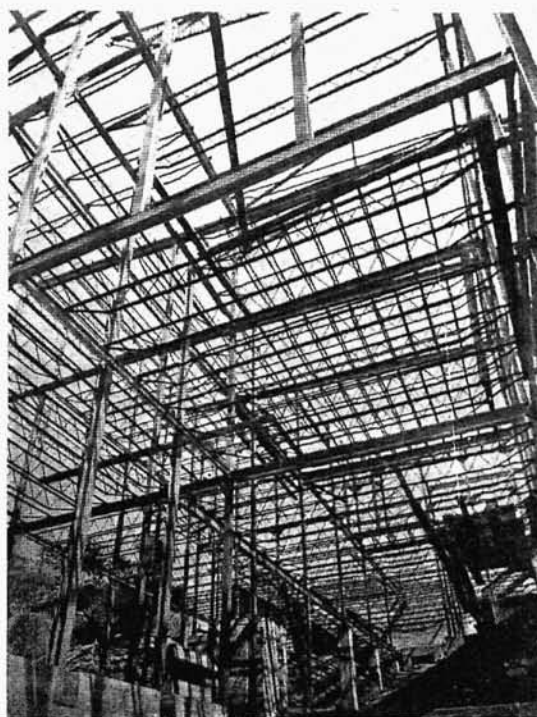
14—15. Konstrukcja żelazna, spawa- wana elektrycz- nie.
