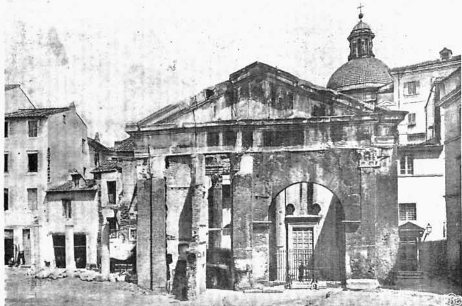
Przed rozpoczęciem robót wykopaliskowych.
