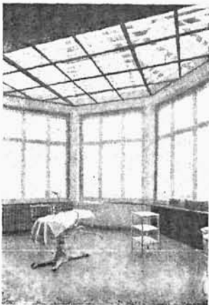
23. Oświetlenie sali operacyjnej rurkami Moor'a.
