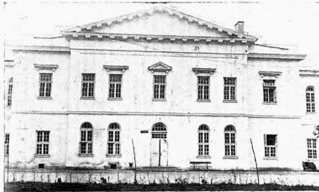
Fragment elewacji dawnego klasztoru OO. Bernardynów, wybudowanego w 1653 r. Obecnie szpital okręgowy, odrestaurowany w 1926–32 r. wg. proj. arch. Juliana Lisieckiego.
