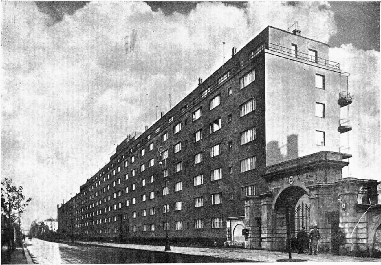
Widok od strony północnej.
