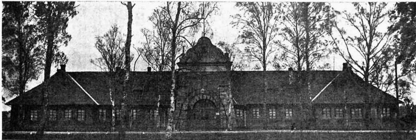
Widok od strony drogi.
