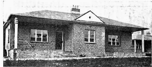
71—72. Arch. Rejek (Poznań). Dom wypoczynkowy podoficerski w Dziewiczej Górze pod Poznaniem, R. 1932—35.
