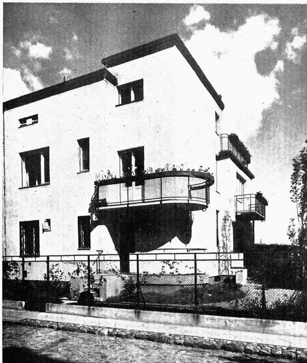
Narożnik domu szeregowego.
