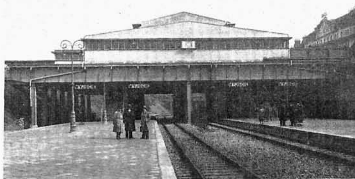
Widok od strony torów.
