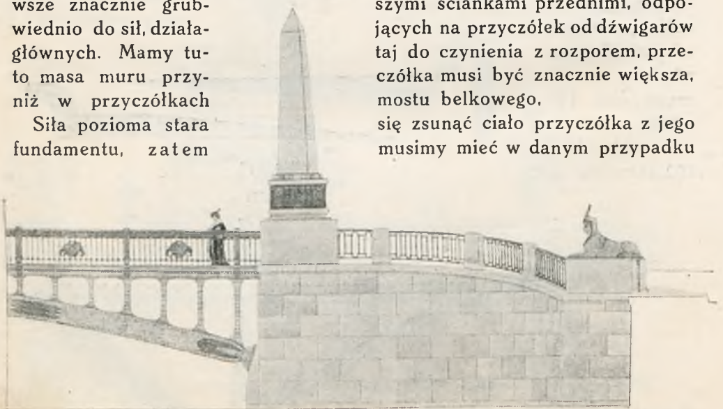
Fig. 150. Przyczółek mostu Egipskiego.
